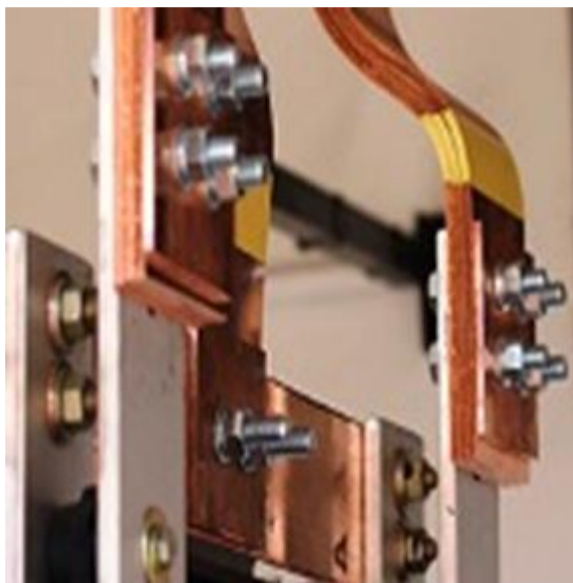
1.1 – сурет - Болтты контактілі қосылыстың мысалы
